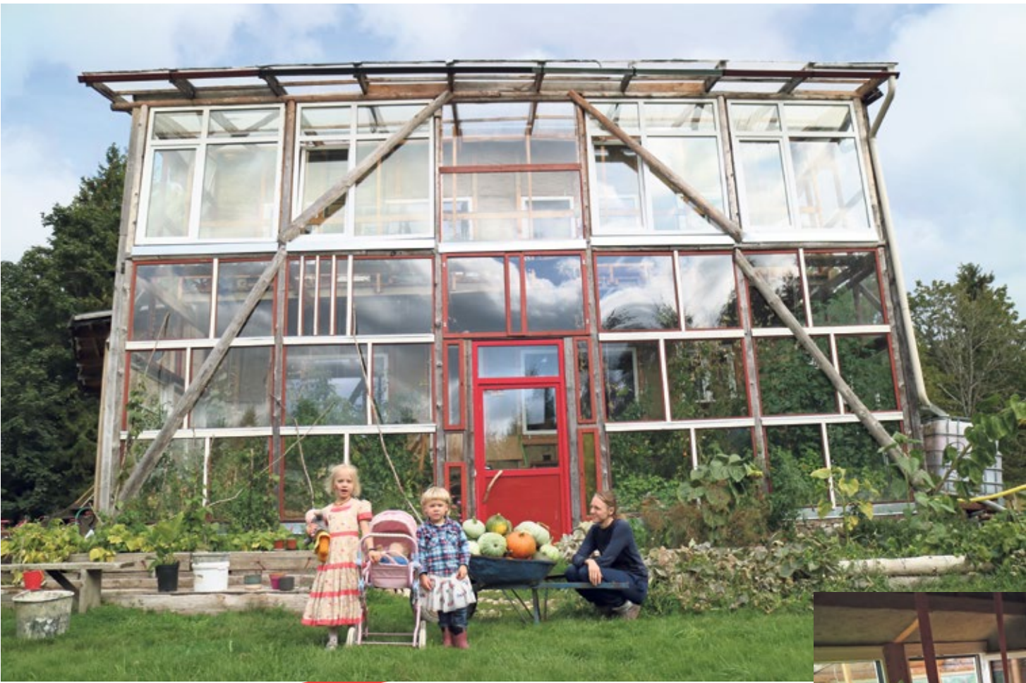
Silveri ja Esteri maja kaasneb põhiliselt vanadest autorehvidest, kodukrundi kuusepalkidest, Võrtsjärve pilliroost, Põhja-Eesti sinisavist, lähimbruse lammutustöödelt pärit akendest-ustest ja ühe kooliväimla põrandalaudadest. Fotod: Silver Tang, Ester Aua
